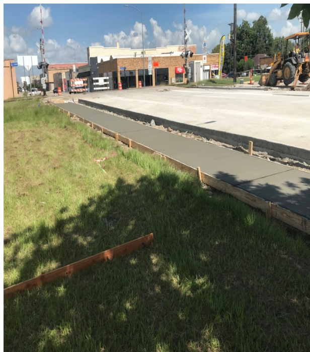
Sidewalk concrete pour at W. Texas Avenue
